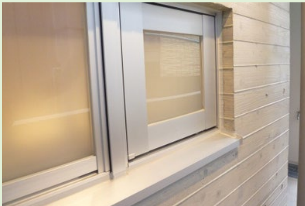
某コンビニエンスストア 水切り
